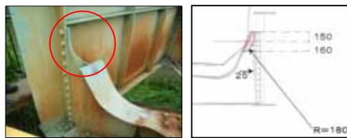
写真2 C橋りょうニーブレス切断状況
