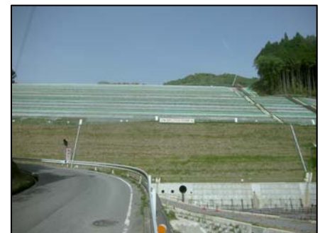
写真-2 酸性土対策盛土
