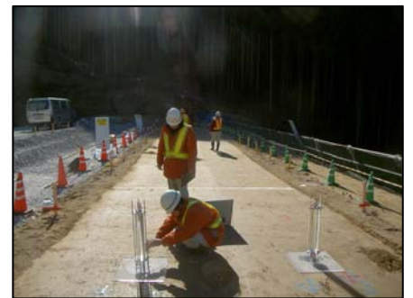
写真-1 現場透水試験
