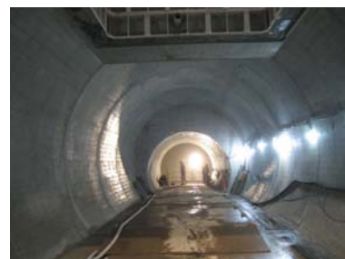
写真-4 覆工完了状況
