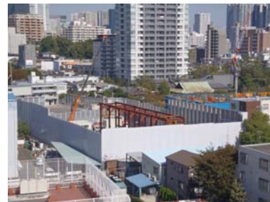
写真-1 工事箇所周辺環境
