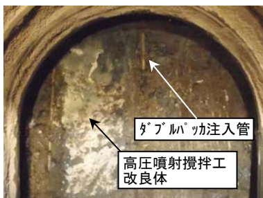
写真-3 上部トンネル切羽状況
