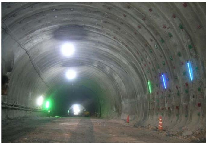
写真-1 光る変位計設置状況
