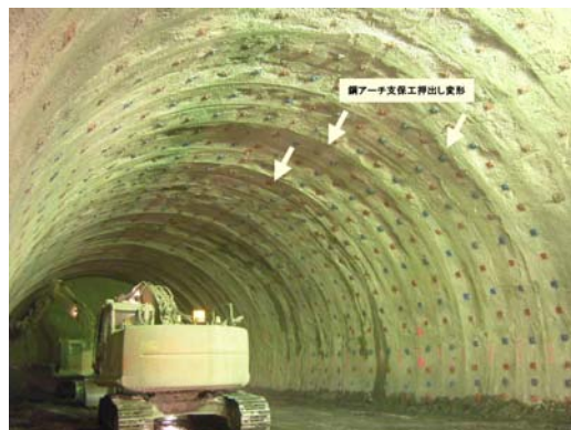
写真-1 トンネル支保構造の変状
