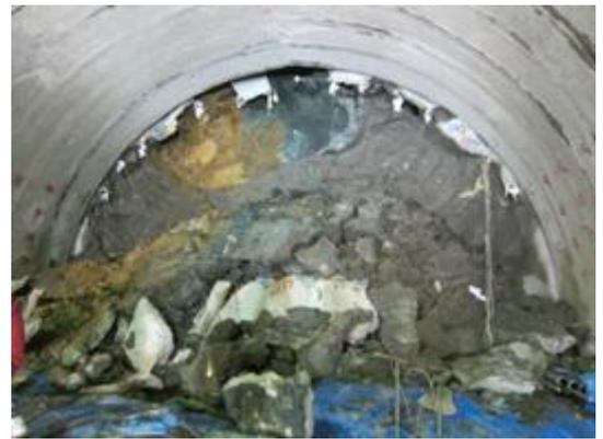
写真-1 長尺先受け工注入開始時切羽崩壊
