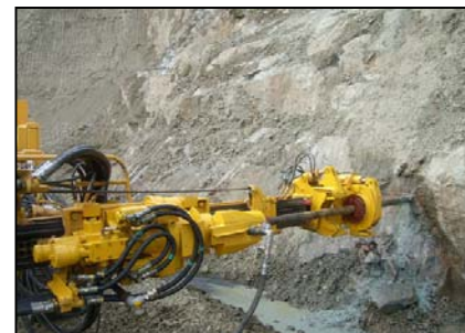
写真-4 トップハンマ式削孔状況(比較用)
