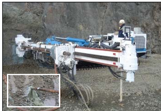
写真-3 削孔状況
