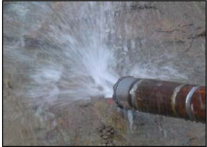
写真-2 水圧ハンマ 削孔水噴射状況
