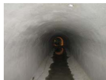
写真-4 中流動コンクリート打設完了
