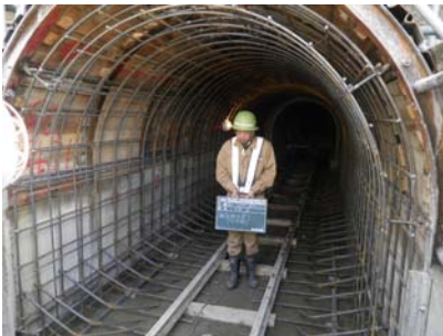
写真-2 下流側坑口部配筋状況
