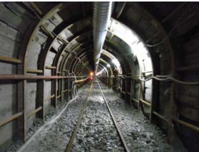
写真-1 坑内状況
