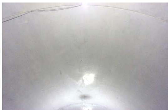
写真-1 中流動覆工コンクリート天端写真
