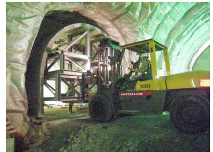
写真-2. プレキャスト部材据付け状況
