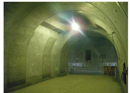
写真-3. PCL工施工完了状況
