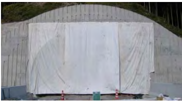
写真-2.1 防風シート
