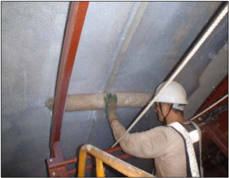
写真-1 シート貼付け状況
