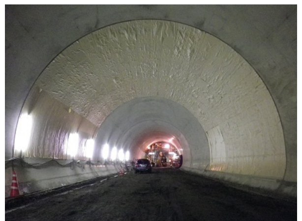
写真-1 養生紙貼り付け状況 (富山県、卯の花トンネル)
