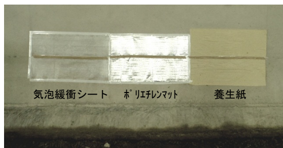
写真-2 測定用シート貼り付け状況
