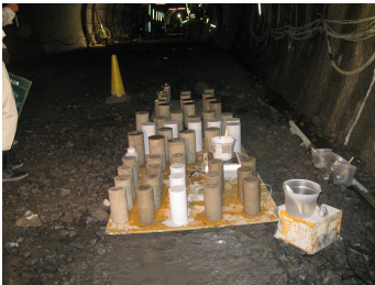
写真-2 現地試験の状況
