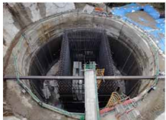
写真1 大口径深礎と橋脚躯体の接合部の状況
