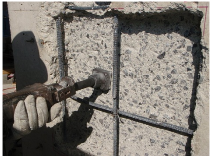
写真-2 仕上げはつり状況
