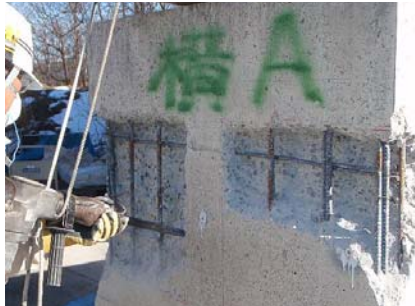
写真-1 はつり状況 (チップー)
