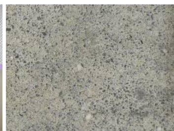
写真-2 対策後の状態
