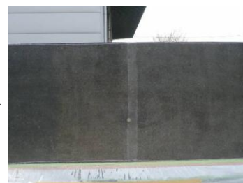
写真-8 施工性確認試験
