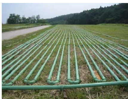
図-4 4 km 鋼管敷設
