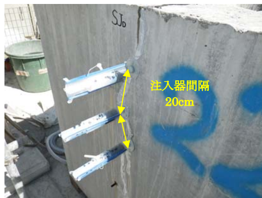
写真 2.1 低圧注入状況
