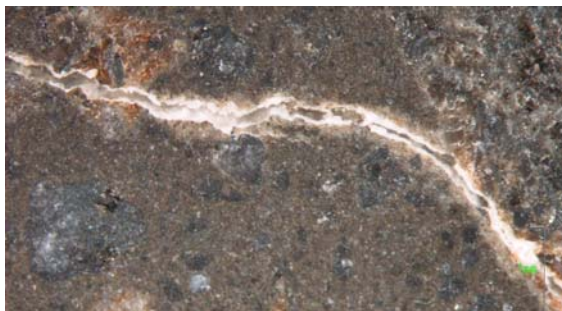
写真 3.2 樹脂 A 低圧注入
