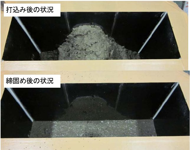
写真-3 下層のコンクリートの施工状況
