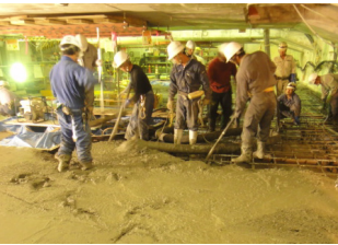
写真-1 コンクリート打設状況
