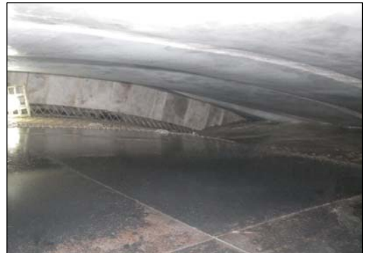
写真-3 コンクリート打設状況
