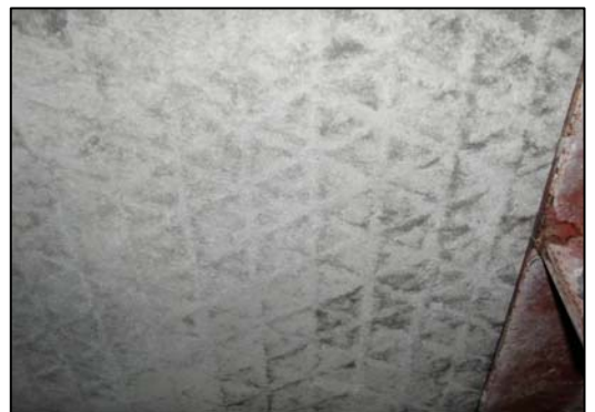
写真-4 コンクリートの表面(打設後1日)
