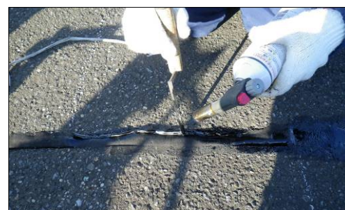
写真-2 施工状況
