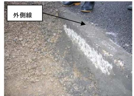
写真-5 左路肩（外側線）側の下層路盤掘削状況
