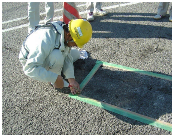
図-2 クラックに削孔した箇所の注入状況
