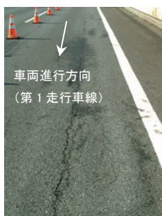
写真-1 橋面舗装表面の例 1 (約 17 年間交通供用)
