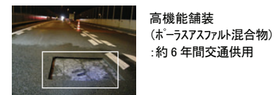
写真-4 基層面の目視調査の例3 (パッチング箇所近傍)
