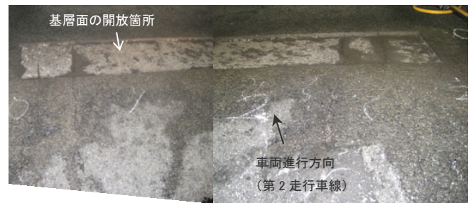
写真-3 基層面の目視調査の例2 (約 17 年間交通供用)
