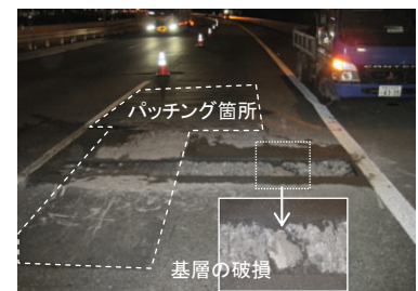
写真-4 基層面の目視調査の例3 (パッチング箇所近傍)
