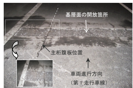
写真-2 基層面の目視調査の例 1 (約 17 年間交通供用)
