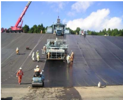
写真-1 施工状況（舗装）
