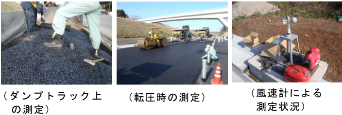
写真-1 現場試験施工での温度測定状況
