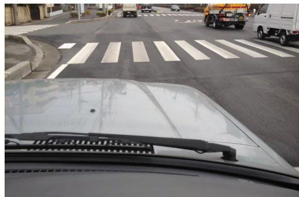
図 4 大振幅応答箇所の路面状況
