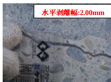
写真-5 充填状況①
