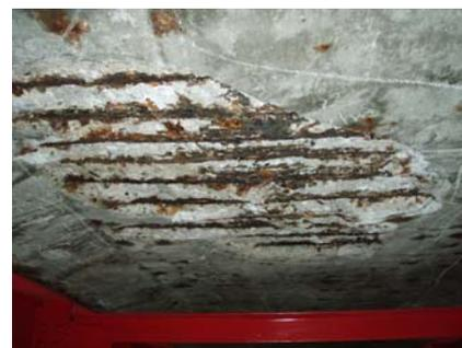
写真-1 RC床版の再劣化事例
