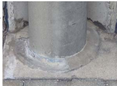
写真-2 PC電化柱損傷状況②
