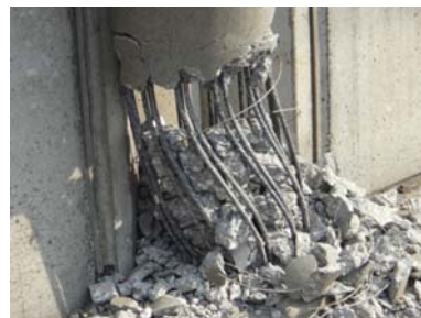
写真-2 PC電化柱損傷状況②
