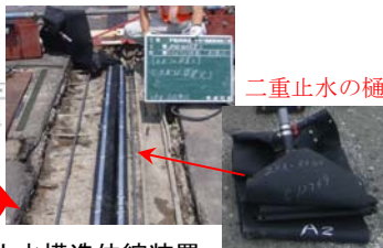
図-3 二重止水構造伸縮装置
