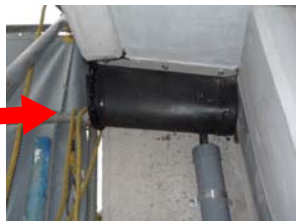
写真-10 端部の漏水対策
