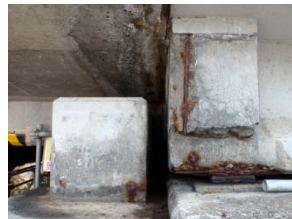
写真-4 桁遊間部の状況
