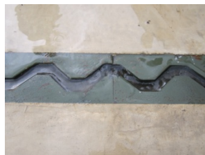
写真-8 継手部の止水状況
