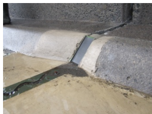
写真-7 地覆部の止水状況
