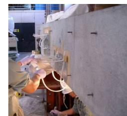
図-2 充てん不良箇所の補修方法
