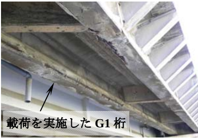
写真-1 撤去前の状況
