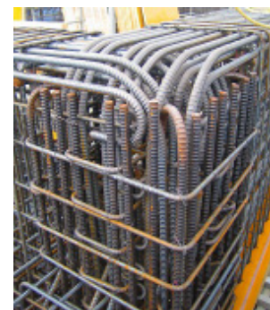
写真-1 配筋状況
