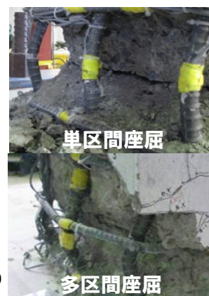
図5 座屈状況の例
