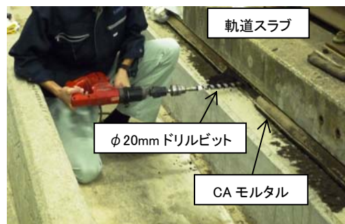
図 1 削孔状況
