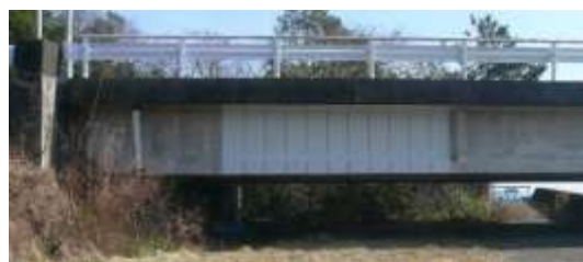
PC橋, 所在地: 三重県, 施工量: 45.28\text{m}^2
