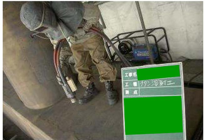
図-3 チタン溶射施工機材
