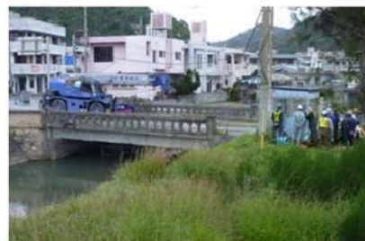
写真-2 載荷試験状況
