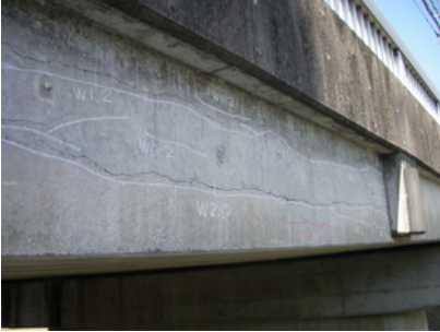
写真-1 主桁側面
