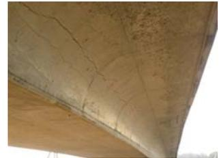
写真-2 ハンチ部に生じた軸方向ひび割れ
