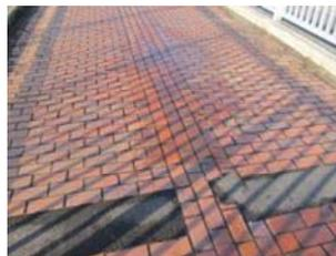
写真-1 中央部付近のレンガ舗装の浮き
