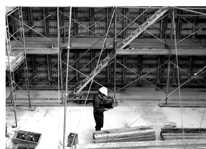
図 1 SS 型枠システムの無線読取状況
