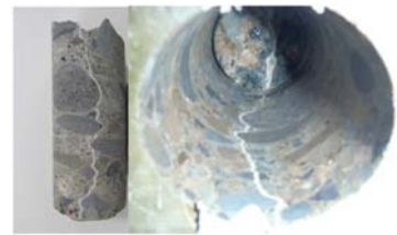
写真-2 削孔コアと削孔内の状況例
