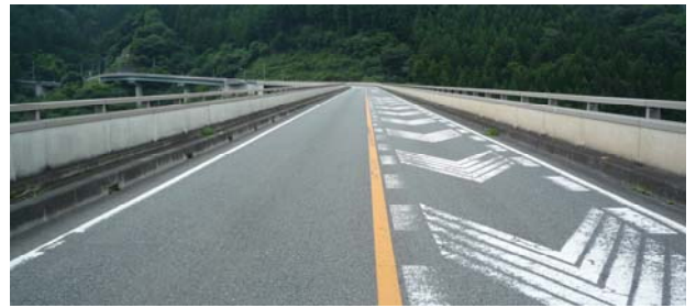
写真 - 2 壁高欄内側の歩道(大滝大橋 P2~P3)
