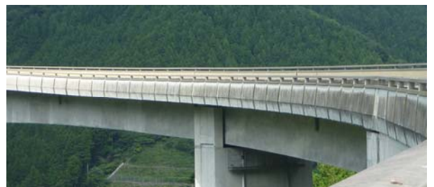
写真 - 1 主桁の外側 (大滝大橋 P2~A1)
