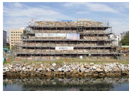
写真-1 城郭石垣全景（積み直し状況）
