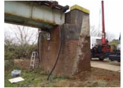
図1 対象橋台全景(背面盛土撤去後)
