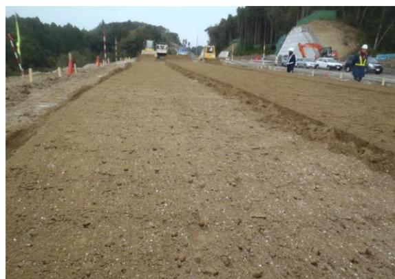
写真1-生石灰 t=20cm 混合後の状況
