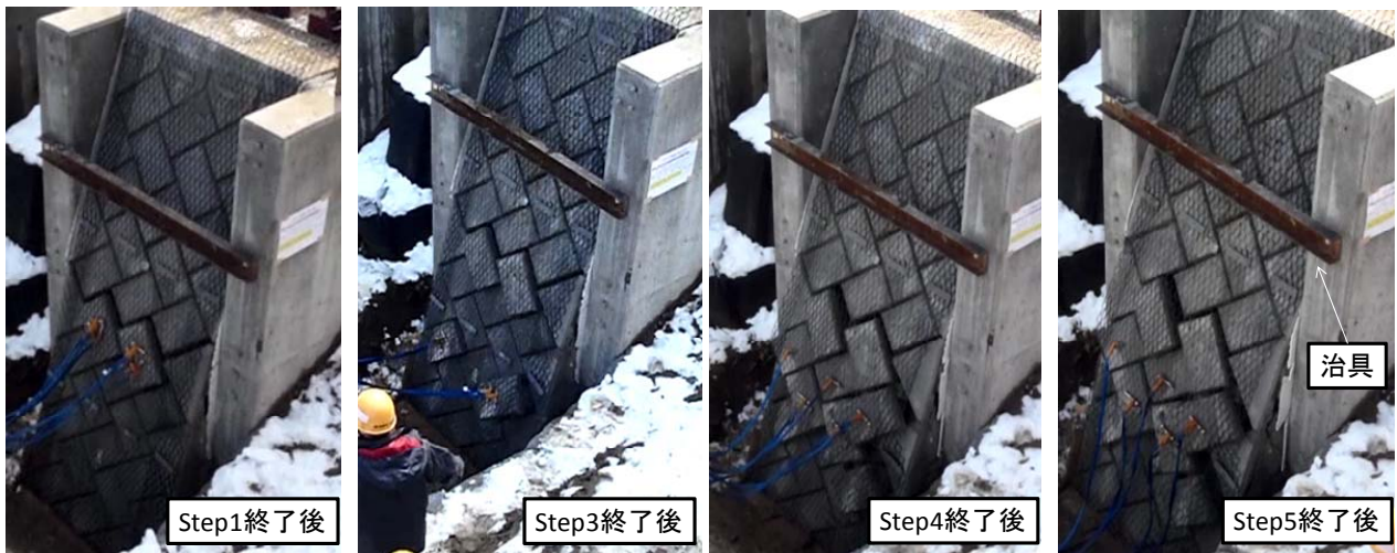
図3 主要ステップ終了時のブロック積み壁の状況
